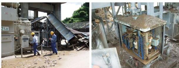
図1 2011年台風12号設備被害（漂流物、浸水）
