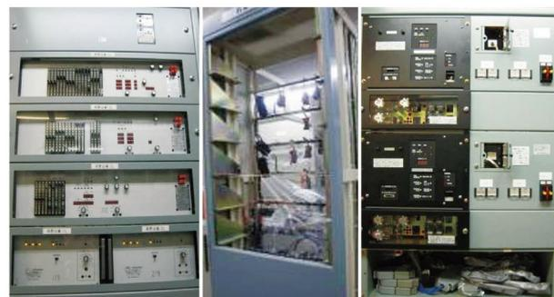
図2 ユニット交換前(左)、取外し(中)、交換後(右)
