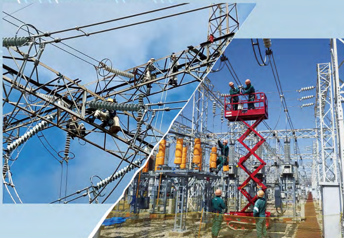
77kV 分岐線接続作業 (2021.3. (株)きんでん)
