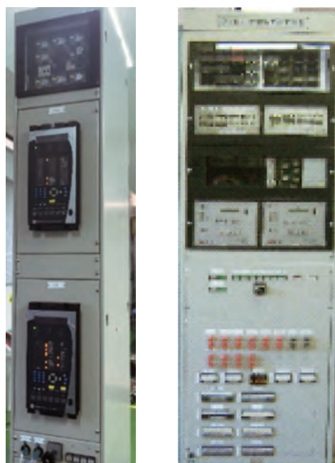
図2 IED実装リレー盤（左）と従来のリレー盤（右）
