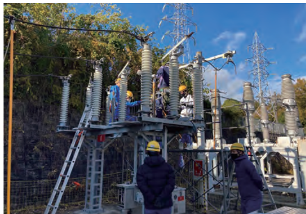
77kV断路器調整研修状況
