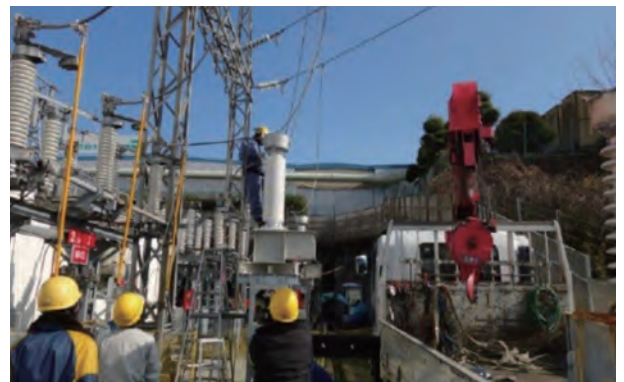
現場コミュニケーション(作業)状況
