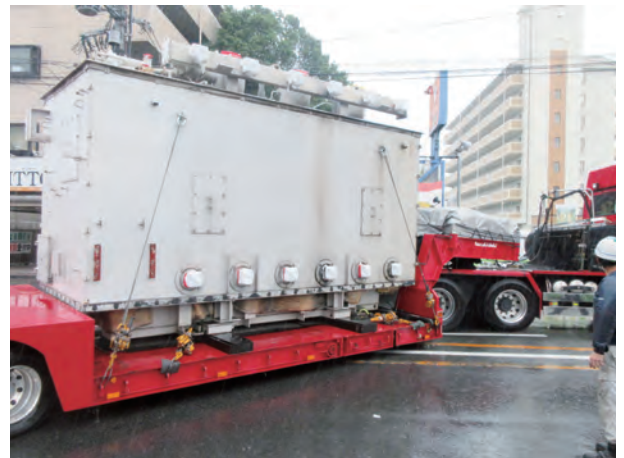
変圧器搬出時の様子
