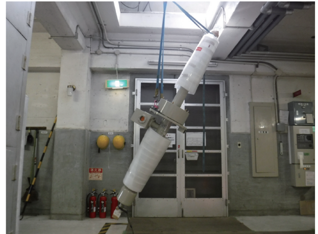
(写真6) ホイストにてブッシング吊上げ状況2
