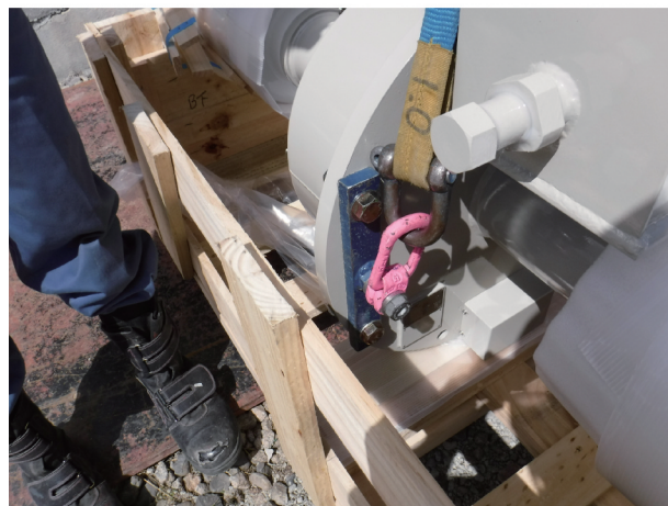
(写真2) フランジ部分にマルチアイボルトの取付
