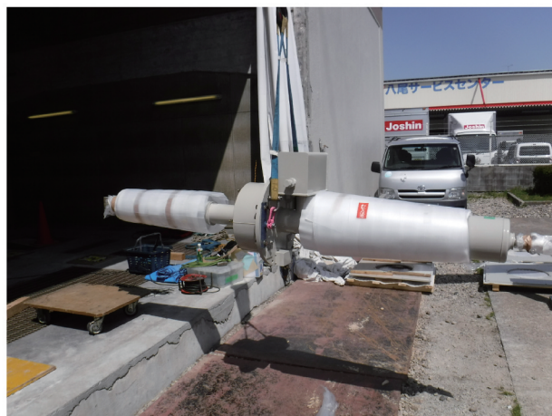
(写真3) ブッシング水平吊り状況
