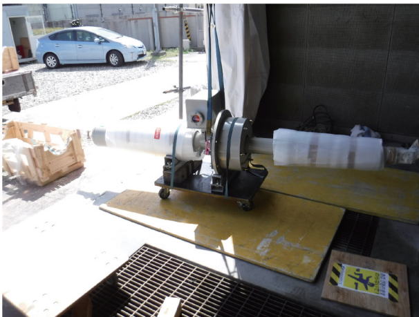
(写真5) ホイストにてブッシング吊上げ状況①
