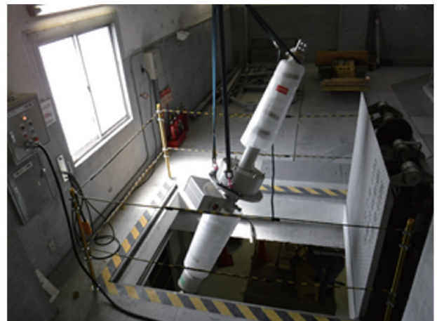
(写真7) ホイストにてブッシング吊上げ状況3
