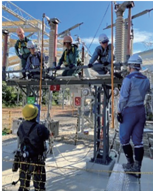
77kV断路器調整研修
