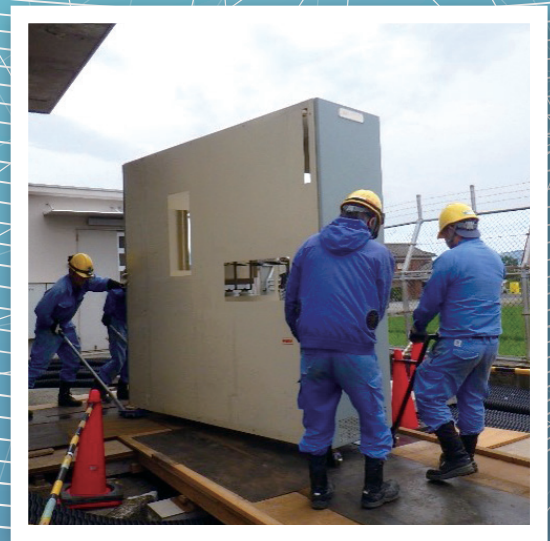
6.6kV キュービクル搬出作業 (紀南電設株式会社)
