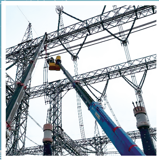
500kV 架線作業 (株式会社サンテック)
