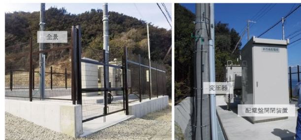
第6図 配電塔(3MVA)改良型外観写真 (新西島配電塔:姫路本部所管)
