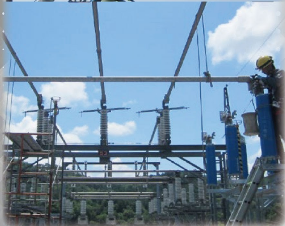
アルミパイプ架線取替作業 (伊藤電気工業株式会社)
