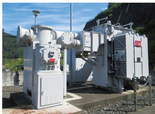
第3図 音海変電所外観写真
